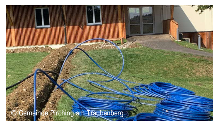
© Gemeinde Pirching am Traubenberg Bau einer Regenwassernutzungsanlage bei der Volksschule in Pirching am Traubenberg
