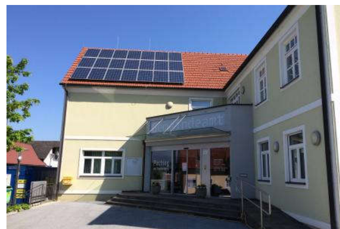
... Notstromversorgung der Gemeinde Pirching am Traubenberg
