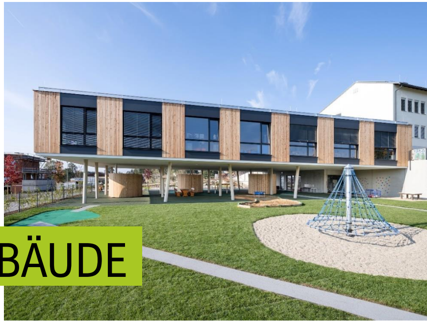
Kindergarten Allerheiligen bei Wildon, Copyright: Archos IT GmbH Architekt Oster
